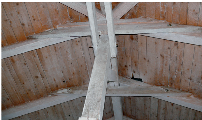
Foto z realizace nátěru Flamgard
