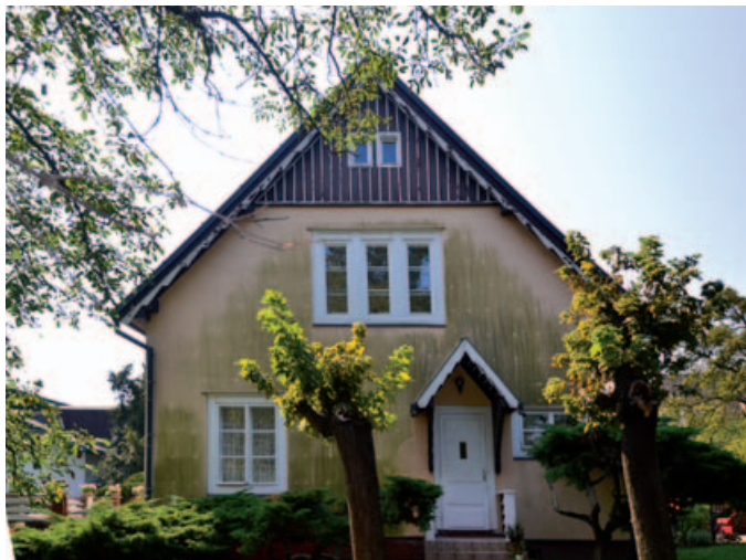
Napadená severní strana domu
