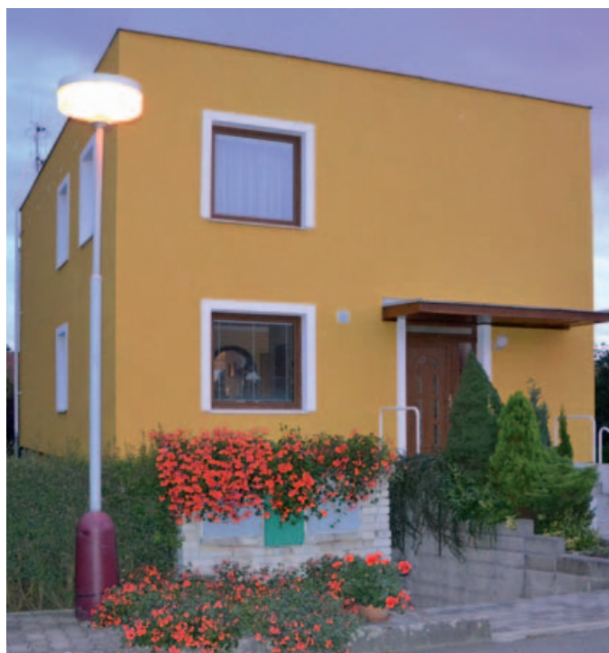
Stav po sanaci
